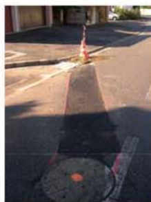
Création d'un caniveau d'évacuation impasse des Roitelets et d'avaloirs supplémentaires rue des Pétouses.
