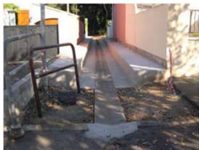
Création d'un caniveau d'évacuation impasse des Roitelets et d'avaloirs supplémentaires rue des Pétouses.
